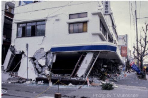
阪神淡路大震災で被災したビル(神戸市)
